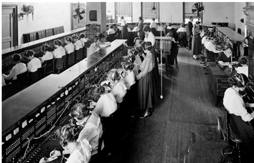
Телефонный коммутатор РМТС
