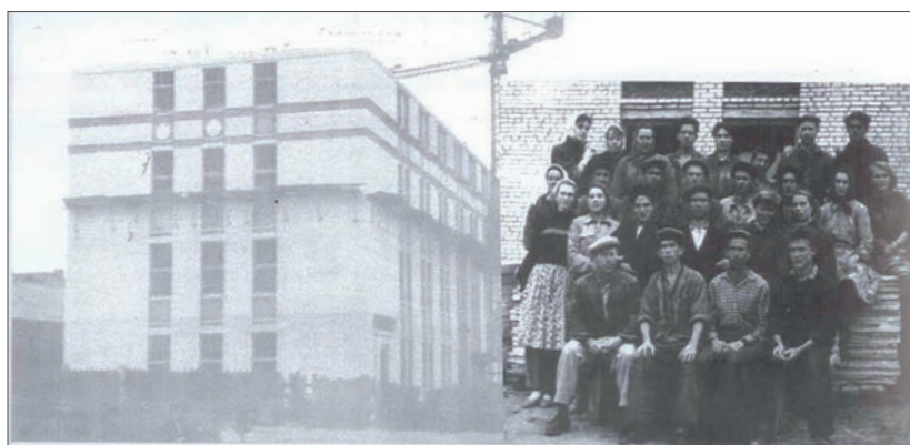
Строительство корпуса № 1 по ул. Платонова.
